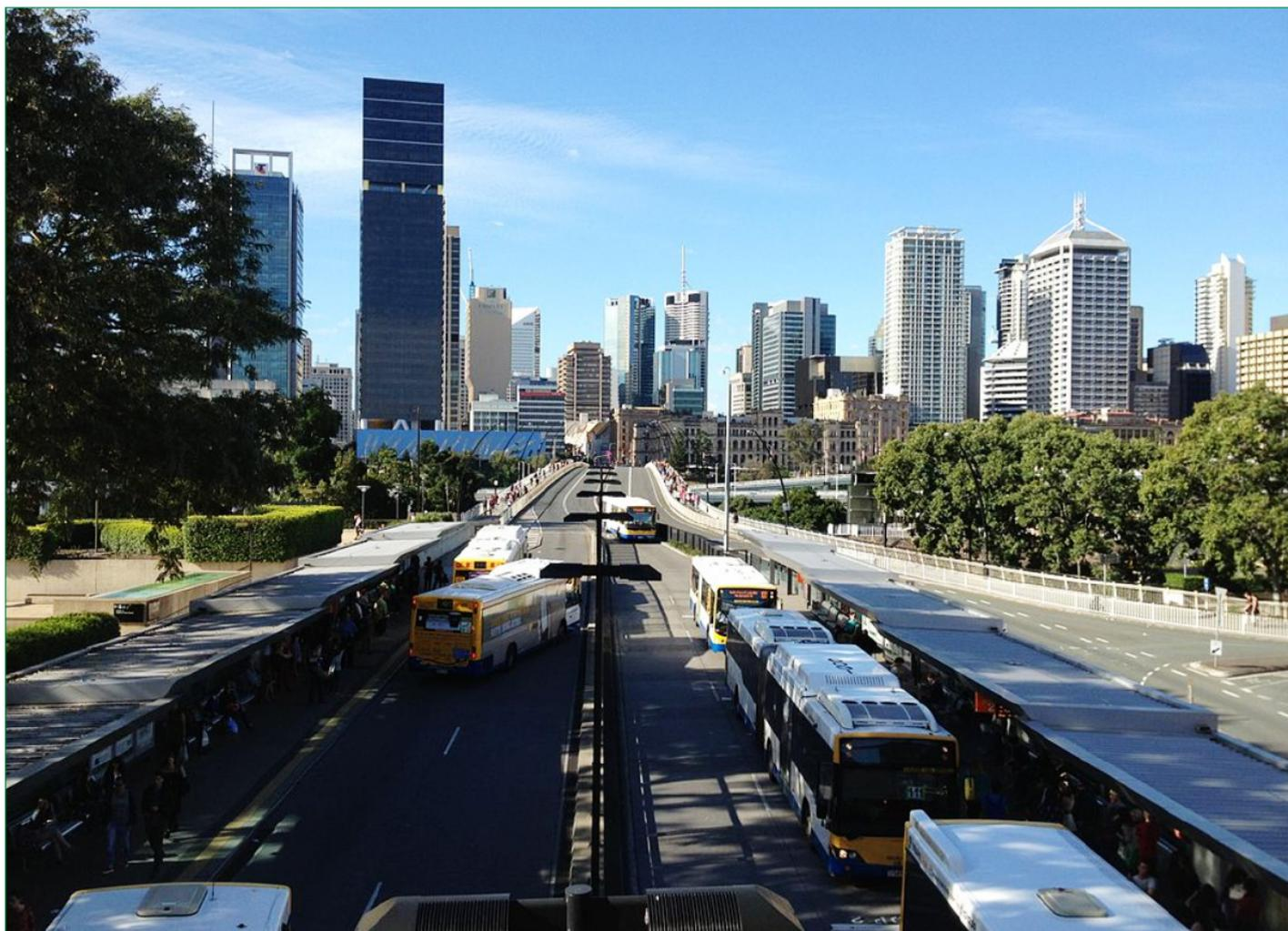
Fonte: foto amatoriale online - Le **Busways** di Brisbane sono corridoi bus in carreggiate proprie estesi per 25 km dove gli autobus viaggiano ad altissima frequenza con picchi prossimi ai 15", in grado di consentire una capacità massima di sistema nell'ordine dei 18.000 pphpd.
